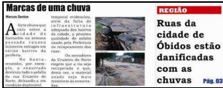
Figura 19. Fortes chuvas danificando ruas em Óbidos.
